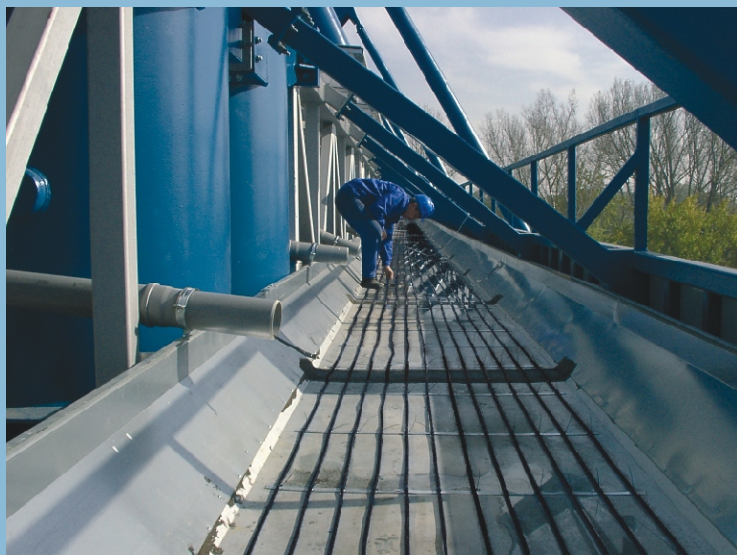
Пример установки нагревательных кабелей на краю крыши
